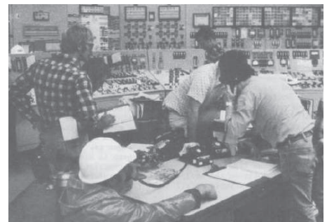
TMI事故後の発電所制御室内の様子（1979年）
